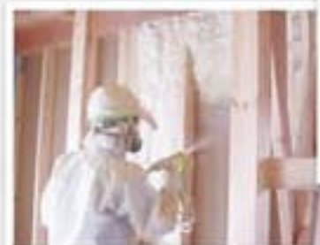
隙間をつくらない水から生まれた環境にやさしい断熱材。厚さ90mm。
