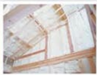
隙間をつくらない水から生まれた環境にやさしい断熱材。厚さ90mm。
